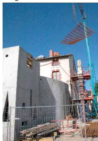
Le futur centre multi-accueil.
