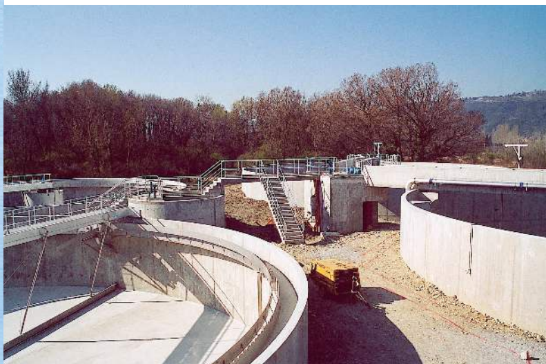
La station d'épuration en phase de mécanisation des bassins.
